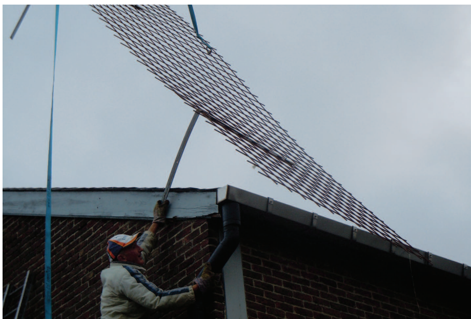
Jan Alen bij het plaatsen van een ijzeren net op het dak van onze militaire loods
